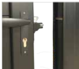
Serrure de coulissant avec pièce de réception et gâche
